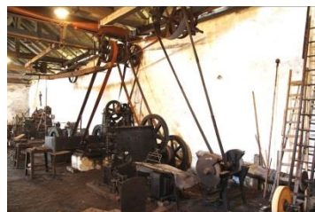
Pohled na podstropní transmissi
